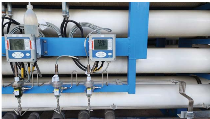
ภาพ แสดงเครื่องวิเคราะห์ Rosemount Model 1056 สำหรับวัดค่าความนำ
