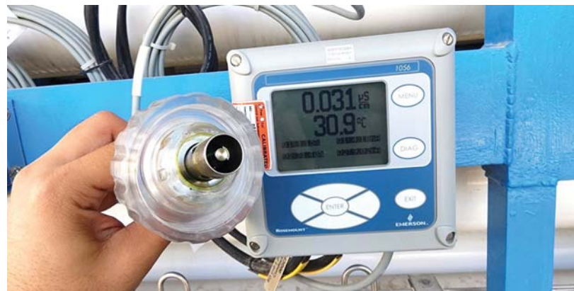
ภาพ แสดงการถอดเซนเซอร์ออกมาทำความสะอาดด้วยน้ำ และทิชชูซับบริเวณหัววัด
