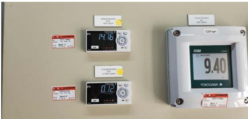
ภาพ แสดงเครื่องวิเคราะห์ DO Yokogawa UM33
