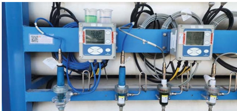
ภาพ แสดงเครื่องวิเคราะห์ความเป็น กรด-ด่าง pH Analyzer Rosemount Model 1056
