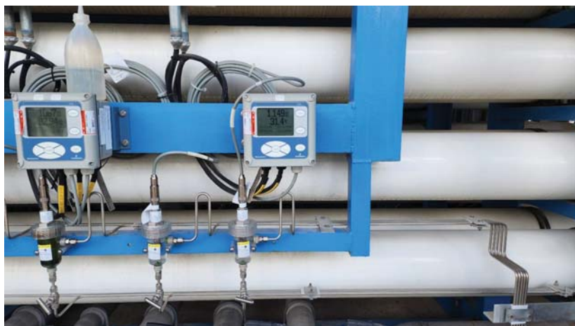
ภาพ แสดงเครื่องวิเคราะห์ Rosemount Model 1056 สำหรับวัดค่าความนำไฟฟ้า
