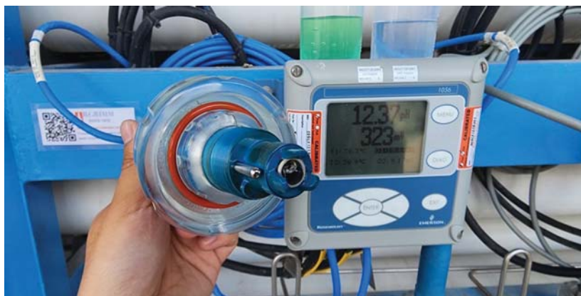
ภาพ การถอดหัวโพรบออกมาเพื่อตรวจสอบ ก่อนทำความสะอาด
